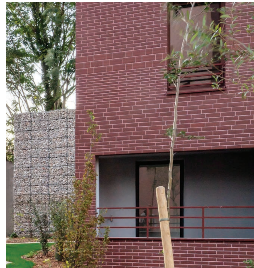
Une présence minérale affirmée : entre briquettes et murs en gabion ↑
